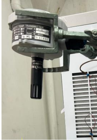
Figura 7. Instalación de sensor de humedad para medición de humedad relativa en la entrada de aire al equipo.
